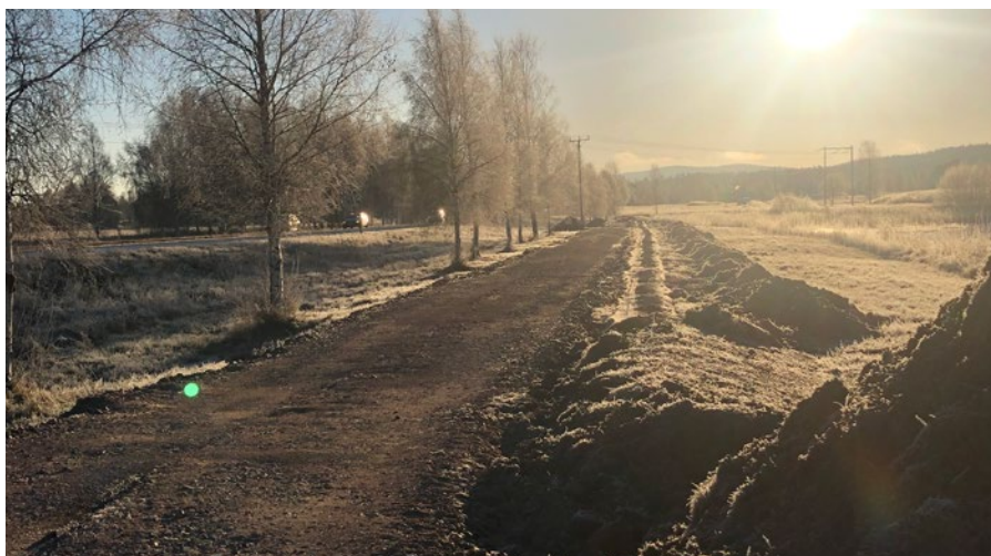
• Området utanför Leksand där DalaFrakt har gjort markarbetet för en tre kilometer lång fjärrvärmeledning. Man ser raksträcken där DalaFrakt grävt.
