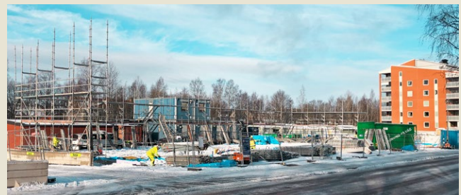
• Här, på Norra Järnvägsgatan i Falun, har DalaFrakt gjort markarbetet som nu gör det möjligt att starta bygget av fastigheter enligt Skanskas och IKEAs BoKlok-koncept.
